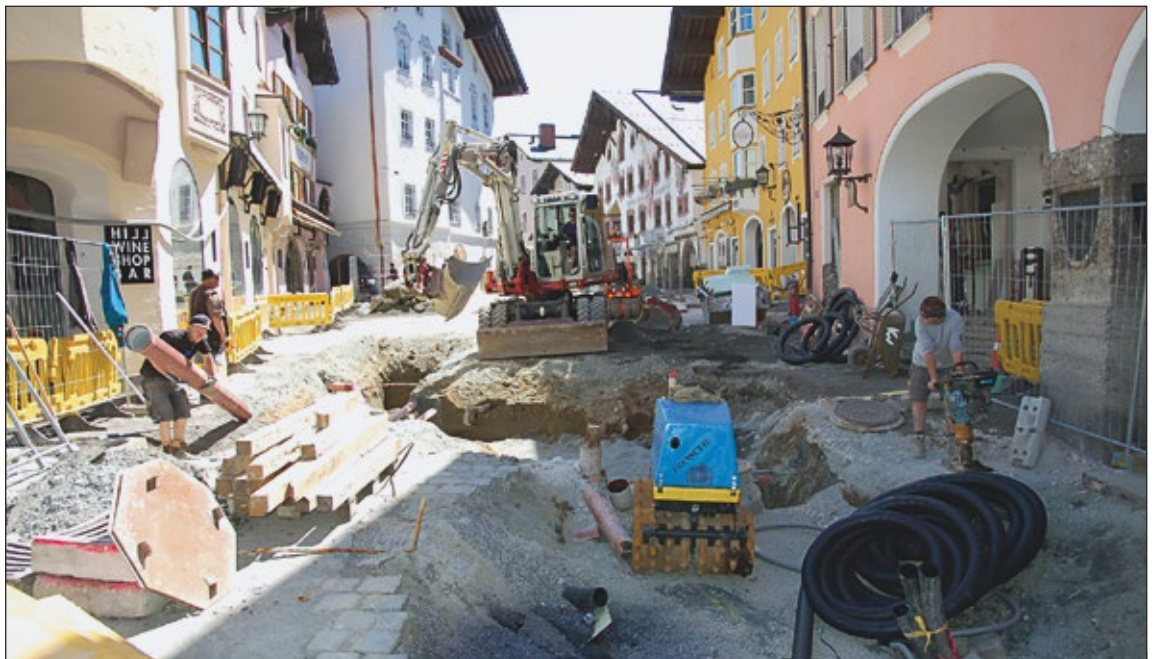
Ein weiteres Teilstück der neuen Pflasterung wurde in der Hinterstadt verlegt.
