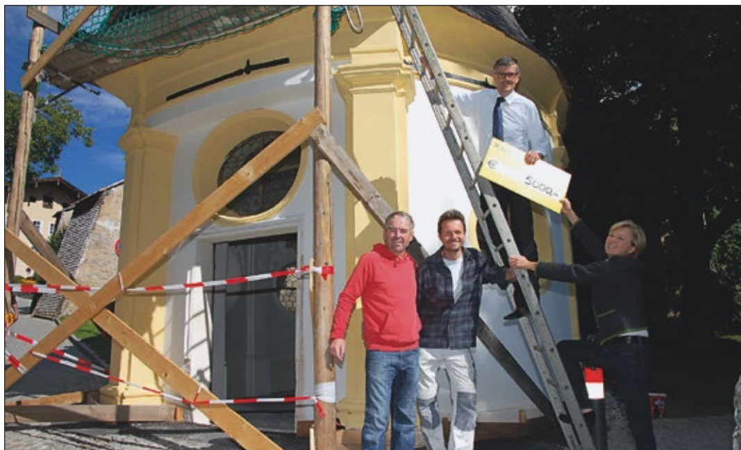
Mit der stolzen Summe von 5.000,- Euro unterstützt Maria Brunner die Sanierung der Johannes-Nepomuk-Kapelle. Bürgermeister Dr. Klaus Winkler und Kulturamtsleiter Hanspeter Jöchl freuen sich über die Zuwendung. Mit im Bild Restaurator Michael Schretthäuser.
