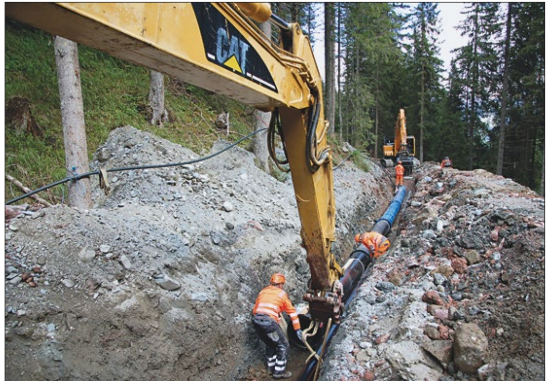
Neben dem Ehrenbach werden die Druckleitungen für das Kraftwerk verlegt.
