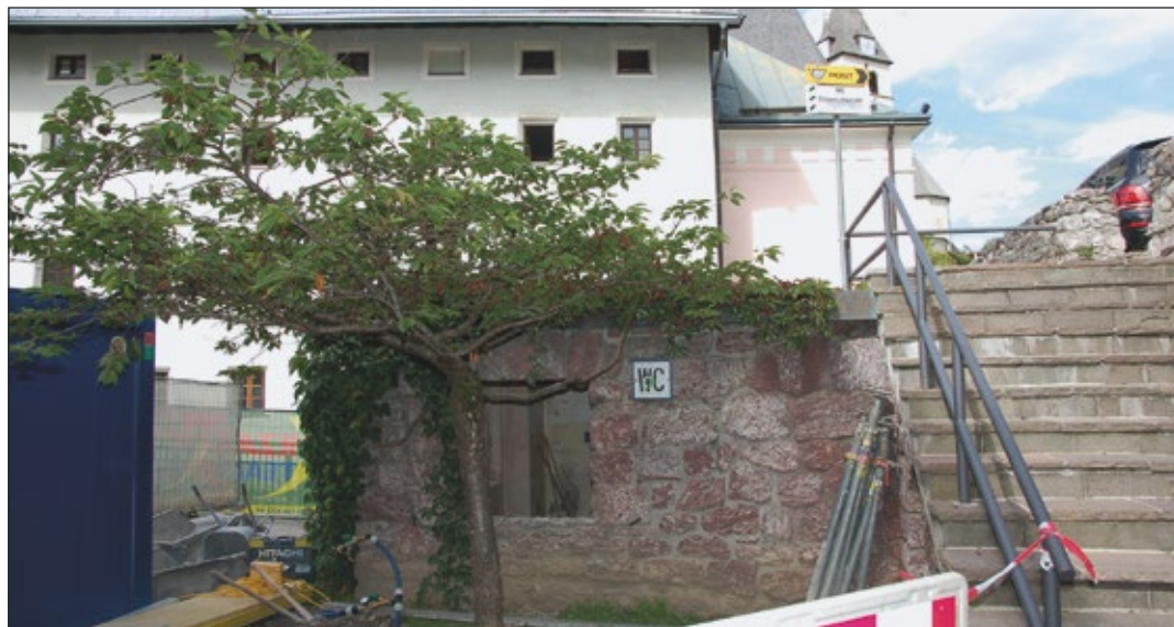
Die WC-Anlage am „Höckbichl“ wird generalsaniert und barrierefrei ausgebaut.
