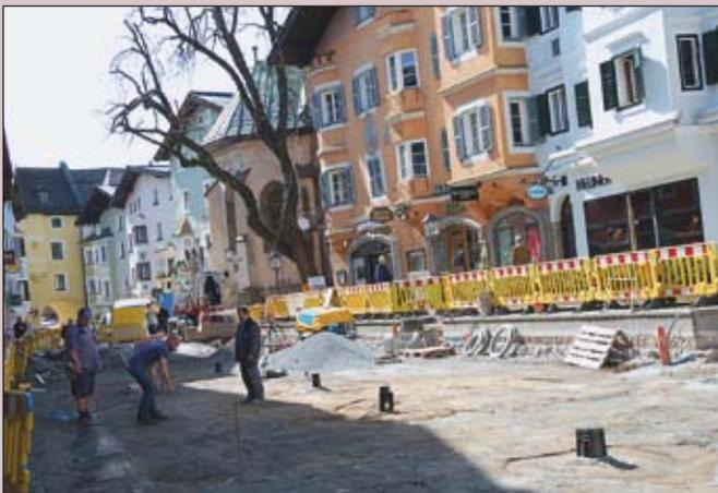
*Die Vorbereitungen für die neue Innenstadtbepflasterung sind voll im Gange. Damit der Granitsteinbelag fugenlos verlegt werden kann, muss der Untergrund entsprechend behandelt werden. Es war auch nötig, den vorhandenen Betonbelag zu entfernen und durch einen neuen Frostkoffer zu ersetzen. Die Arbeiten dauern noch bis Anfang Juli.*
