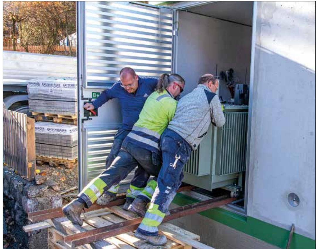
Gemeinsam wird der 2,8 t schwere Trafo hineingeschoben.
