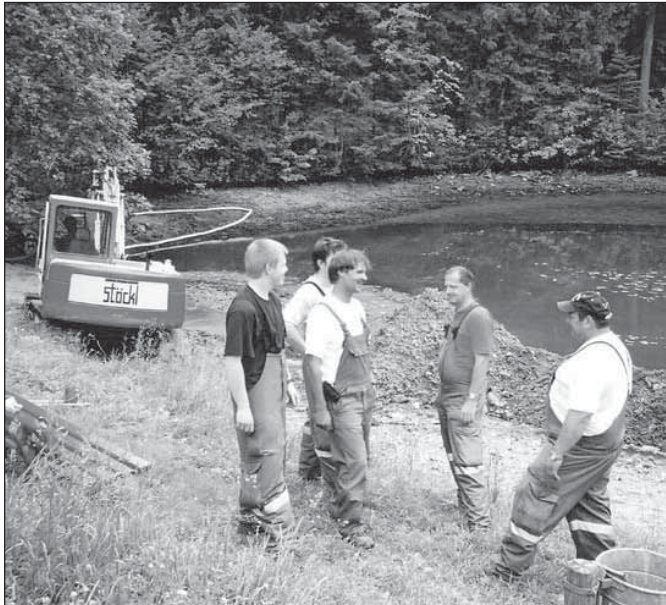
Die Kitzbüheler Feuerwehr half bei der für die Bauarbeiten notwendigen weiteren Absenkung des Wasserspiegels am Vogelsberger Weiher mit.
