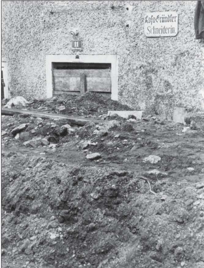
Vermurung bis in Erdgeschosshöhe
