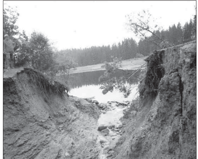
Dieses historische Foto zeigt den Dambruch am Gieringer Weiher nach schweren Unwettern Anfang August 1977. Eine bedrohliche Wassermasse ergoss sich durch das Weiherbachtal bis zum Steinbergbauern nach Oberndorf und richtete einiges an Verwüstung an, wie durch ein Wunder kamen keine Personen zu Schaden. Seit der Neuerstellung des Dammes verläuft die Zufahrt zum Gieringer Weiher nun nicht mehr über diesen. Die Stadt Kitzbühel leistete seinerzeit große Baukostenbeiträge.
