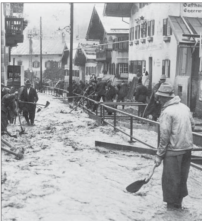
Der Blick abwärts zeigt den Umfang der Wassermassen
