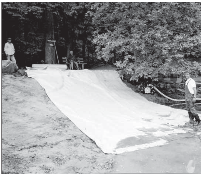
Gerhard Hirschbichler vom Tourismusverband initiierte und leitete die Arbeiten zur Sanierung des Staubereichs am Vogelsberger Weiher. Dieser wurde fachgemäß abgedichtet. Undichtheiten waren im übrigen auch in den 90er Jahren aufgetreten, in den späten 60er Jahren war der Weiher nahezu ganz ausgeronnen.
