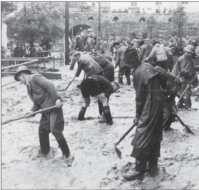
Komplette Überflutung der Unteren Gänsbachgasse
