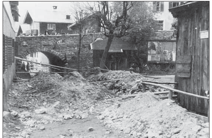
Situation oberhalb des Durchlasses
