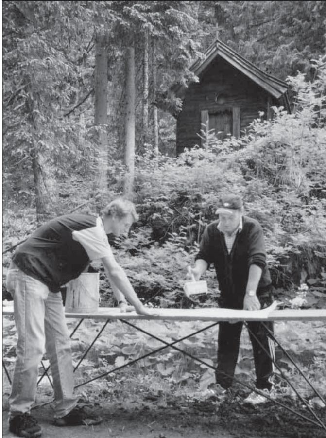
Die auf einem Felsklotz oberhalb der Ehrenbachschlucht befindliche kleine Kapelle „St. Wendelin“ ist in Lage und Bauweise eine Rarität und gehört der Stadt Kitzbühel. Das Innere war seit längerem renovierungsbedürftig. Josef „Buwei“ Messenlechner und sein Neffe Thomas Nothegger nahmen sich in einer mehrtägigen Aktion der
