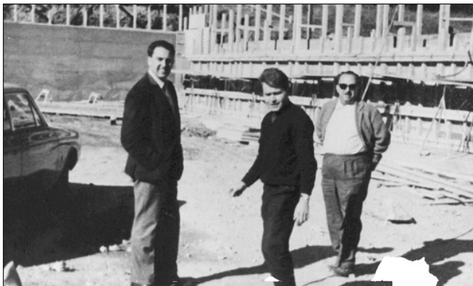
Otto Hölzl, Hellmuth Dieter Küchenmeister und Hubert Leitner (von links) im Oktober 1965 auf der Baustelle der Kunsteisbahn an Lebenberg
