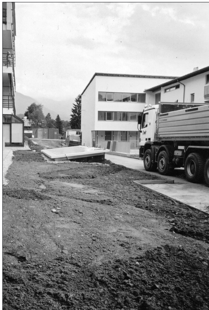
Endspurt beim Zubau Altenwohnheim: Der zur Gänze mit Funktionsräumen unterkellerte Hof zum Krankenhaus wird oberirdisch soweit als möglich begrünt, weshalb Humus aufzubringen war.
