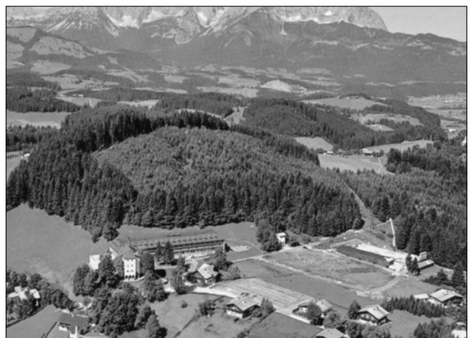
Luftaufnahme des Lebenbergs aus den 60er Jahren nach Errichtung der Kunsteisbahn. Diese und der Hotelbau bildeten den Beginn der Verbauung dieses in zahlreicher früherer Literatur gerühmten Kitzbüheler Naherholungsgebietes. Der Lebenberg ist der südlichste Ausläufer der von der Eiszeit so hervorragend geformten Landschaft des „Bichlach“, welches beim Kitzbüheler Mesnerhaus beginnt und sich bis zum Wilden Kaiser erstreckt.
