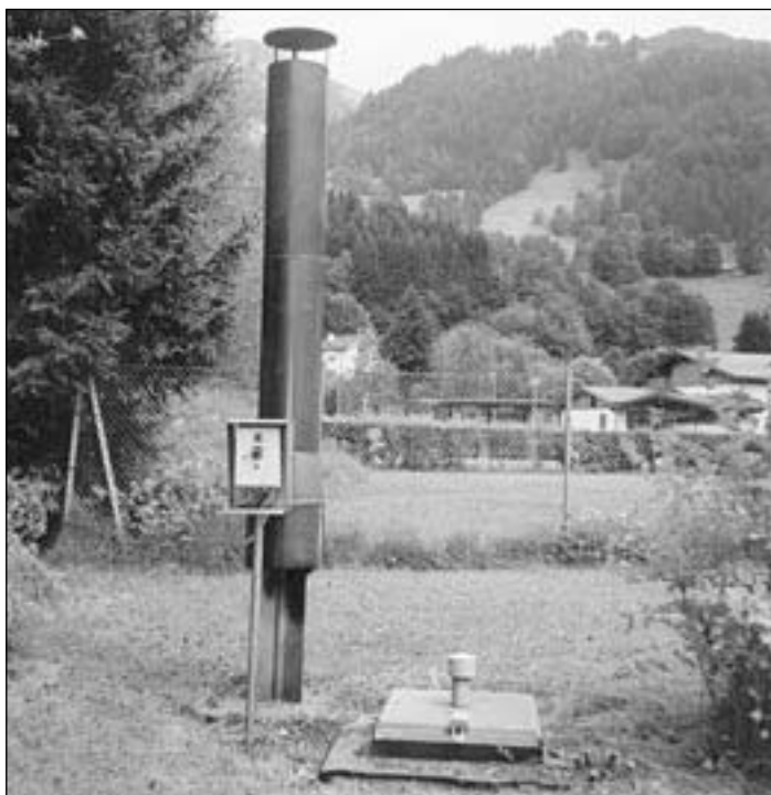
Die Gasfackel zur Verbrennung des anfallenden Klärgases wird künftig nur noch für Notfälle bereitgehalten.
