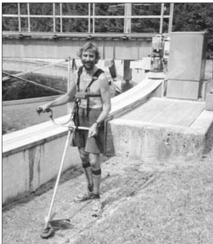
Ausgezeichneter Zustand der Kitzbüheler Verbandskläranlage, auf Pflege und Wartung wird viel Augenmerk gelegt.
