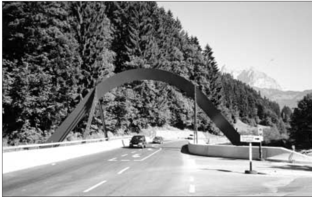
Provisorisch zum Verkehr freigegeben: Schwarze Brücke
