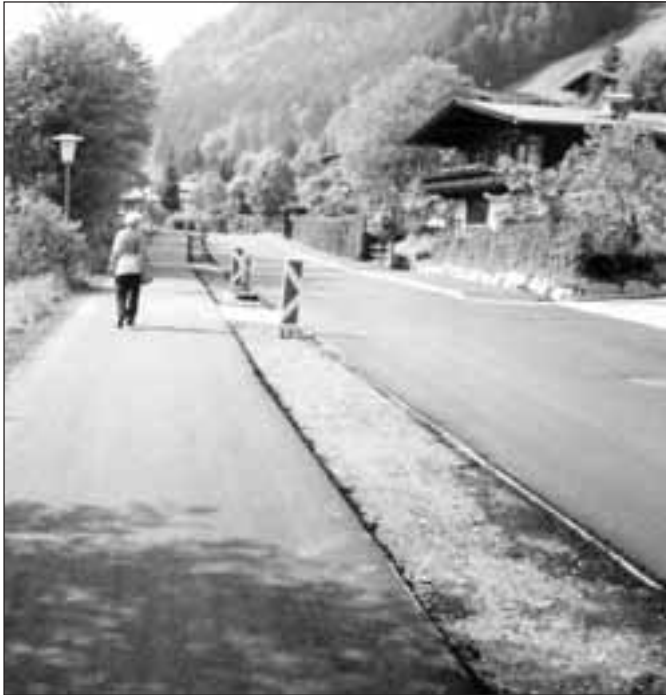
Bauliche Maßnahmen am Einfangweg sind nahezu fertig gestellt.
