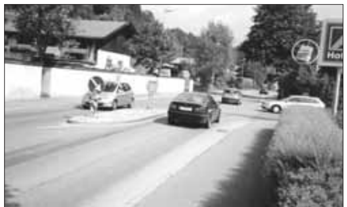
Schwierige Situation in der St.-Johanner Straße, der Fahrbahnteiler soll Kollisionen mit den aus dem Supermarktbereich einbiegenden Fahrzeugen verringern.
