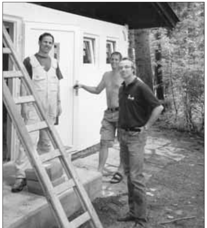
Die aus den 60er Jahren stammende Sanitäranlage im Wäldchen neben der Liegewiese wird mit erheblichen Mitteln modernisiert
