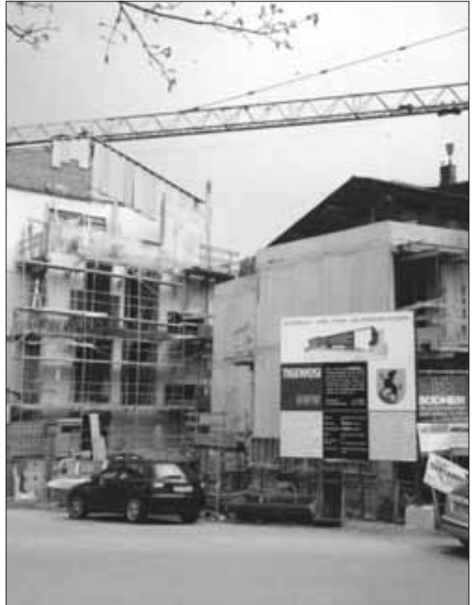
Die straßenseitigen kleineren Zubauten beim Altenwohnheim nehmen Gestalt an. Hier entstehen zusätzlich vier Zimmer sowie ein neuer Eingangsbereich in die Verwaltung im Parterre. Angelegt wird auch ein Verbindungsgang vom dritten Geschoss des Altenwohnheims in den zweiten Stock des Krankenhauses. Bei diesem sind wegen der neuen Küchenlüftung überdies Balkonverkleidungen anzubringen.
