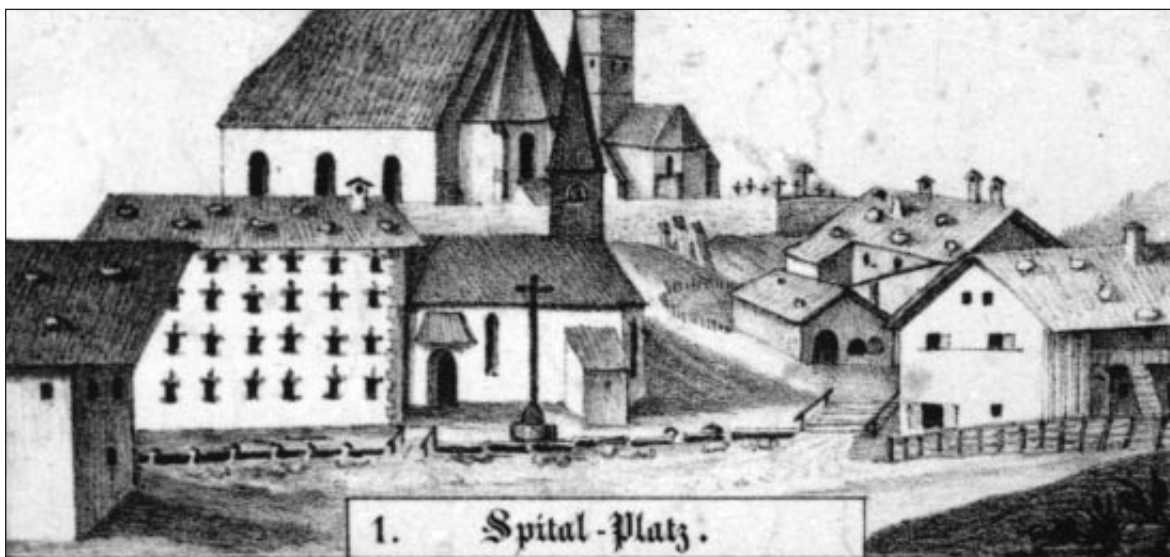
Der Spitalplatz war die ehemalige „Kirchgaß“. Die gotische Spitalskirche aus 1412 musste dem Straßenbau weichen. Das Abbruchmaterial der Kirche wurde für den Aufbau der neuen Straßenrampe verwendet. Im Gänsbachdurchlass sind die gotischen Gewölberippen heute noch deutlich zu sehen.
