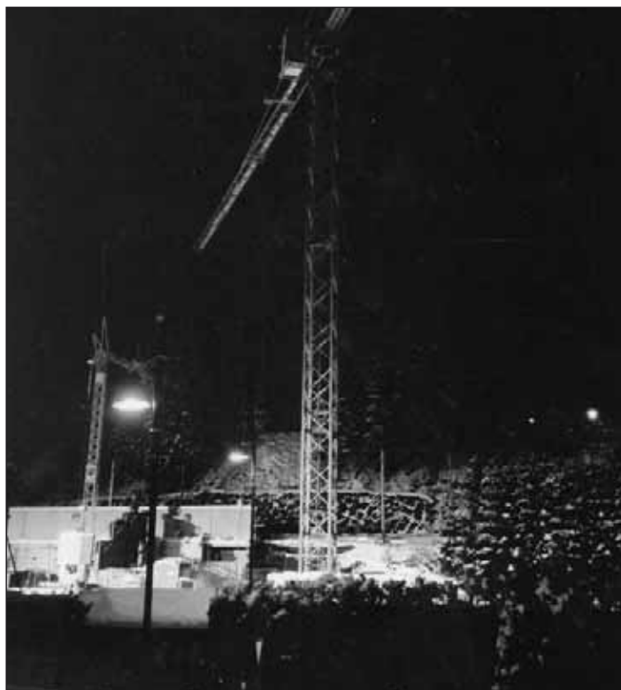
Die Bauzeit ist knapp beim neuen Sportpark Kaps. Deswegen gibt es keine Winterpause und auch bis in die Nachtstunden hinein wird unter Flutlicht gearbeitet.
