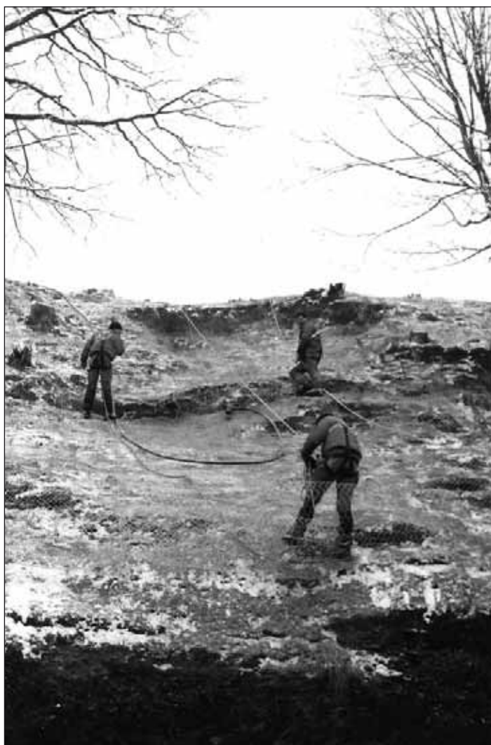
Schwerarbeit bei eisiger Kälte am Höglabbruch, an Seilen hängend werden mit dem Kompressor die Löcher für die Verankerung des Schutzgitters gebohrt, der Palven wird anschließend „gefesselt“.
