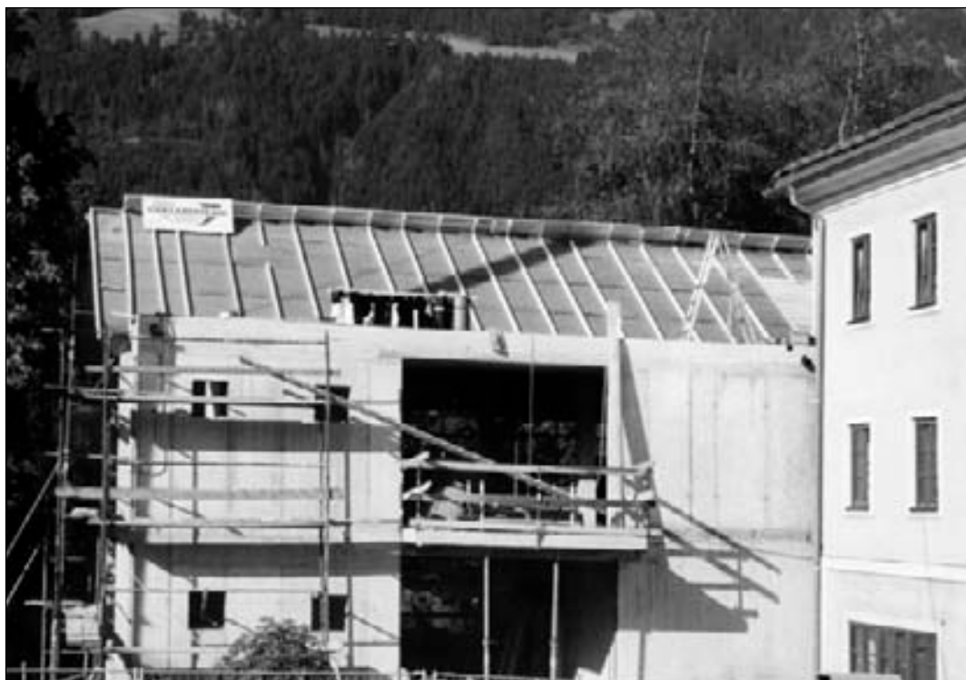
Der Erweiterungsbau beim Marienheim nimmt entsprechende Form an, im Bild der nordwestseitige Trakt, in dem der Vortragssaal entstehen wird.
