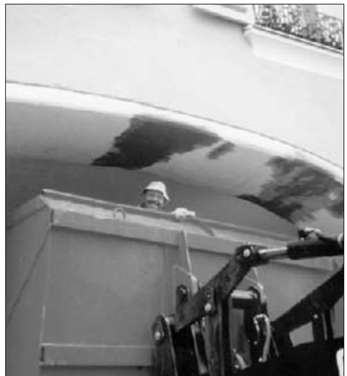
Trotz der relativ großen Durchfahrtshöhe und ausreichender Beschilderung wird das Rathaustor von Großfahrzeugen alljährlich laufend beschädigt. Vor Beginn der Sommersaison muss die Beschädigung dann immer repariert werden, damit verbunden ist ein ebenfalls jährliches Ausmalen, sodass das Tor dann wenigstens zur Hochsaison und vor allem zum Jahrmarkt entsprechend ansehnlich ist. Geht es nach dem Bild, so hat Stadtmaurer Gottfried Arnold Freude an seiner Arbeit.
