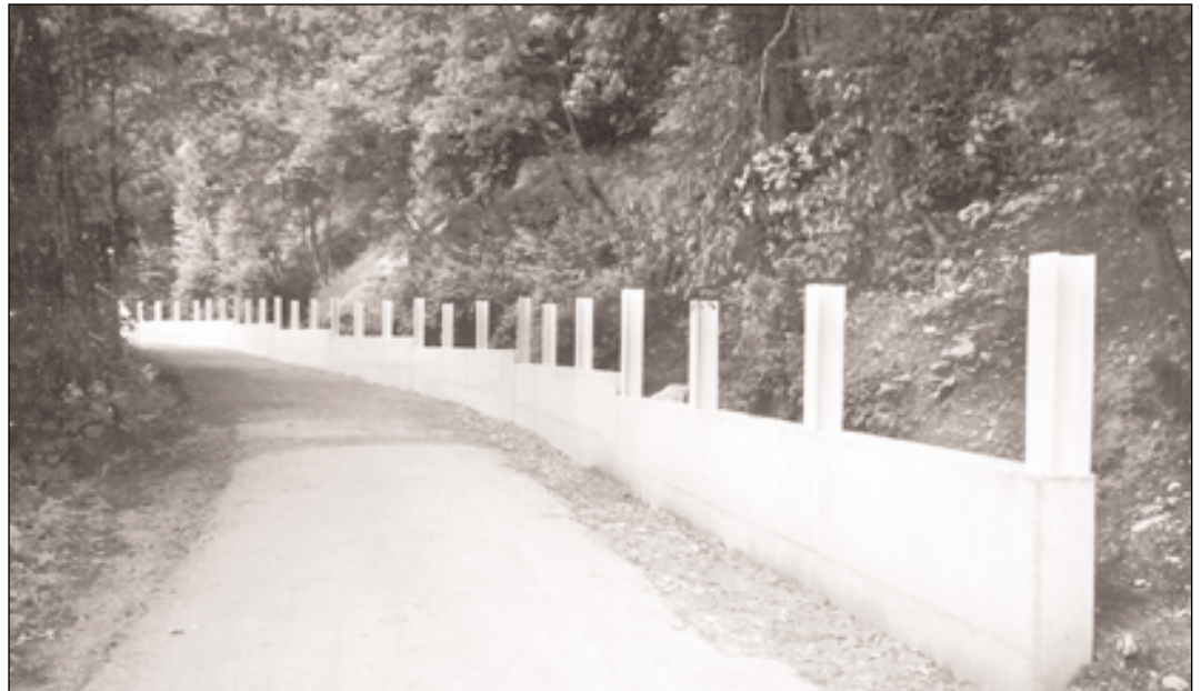
Diese Mauer unterhalb des Högls am Eingangsweg beschäftigte den Gemeinderat (siehe Bericht). Die von der Firma Gerzabek erstellte Mauer mit Stahltraversen soll vom Bauhof noch um die Holzbedeckung ergänzt werden. Auch um die nachträgliche Absegnung der Auftragsvergabe gab es im Gemeinderat Geplänkel, FPÖ-Mandatar Dander ist Geschäftsführer bei Gerzabek.
