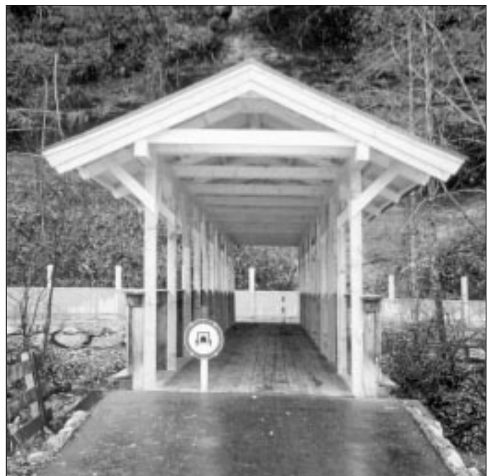
Die Fußgängerbrücke über die Kitzbüheler Ache am Eingangsweg wurde kürzlich mit einer Überdachung ausgestattet.
