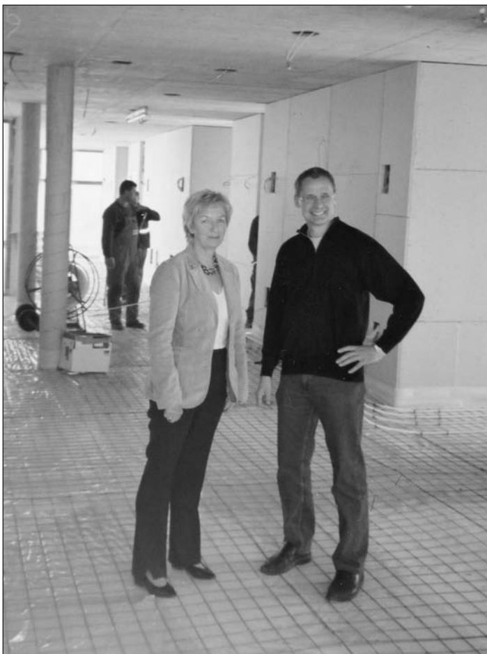
Stadträtin Rief und Geschäftsführer Hauser freuen sich über den sichtlichen Baufortschritt.
