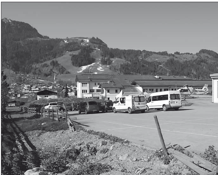
Die Rehabilitationsklinik der Firma VAMED wird in diesem Bereich errichtet. Der Hubschrauberstützpunkt (rechts) muss dem Projekt weichen.
