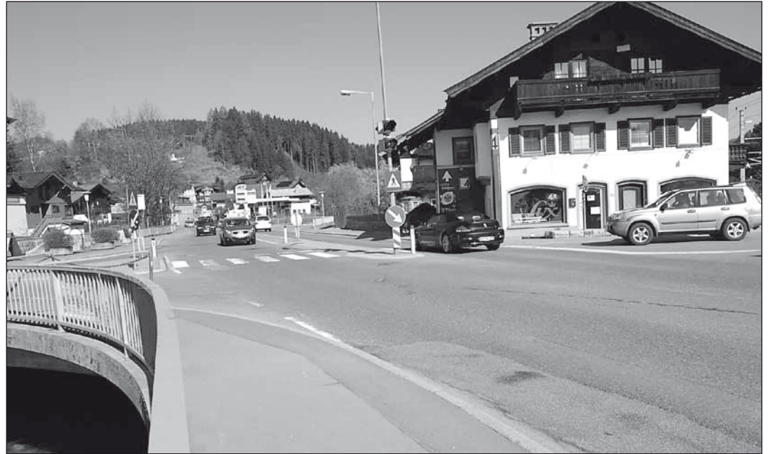
Die aus den 1960er Jahren stammende Hornbrücke wird komplett erneuert.
