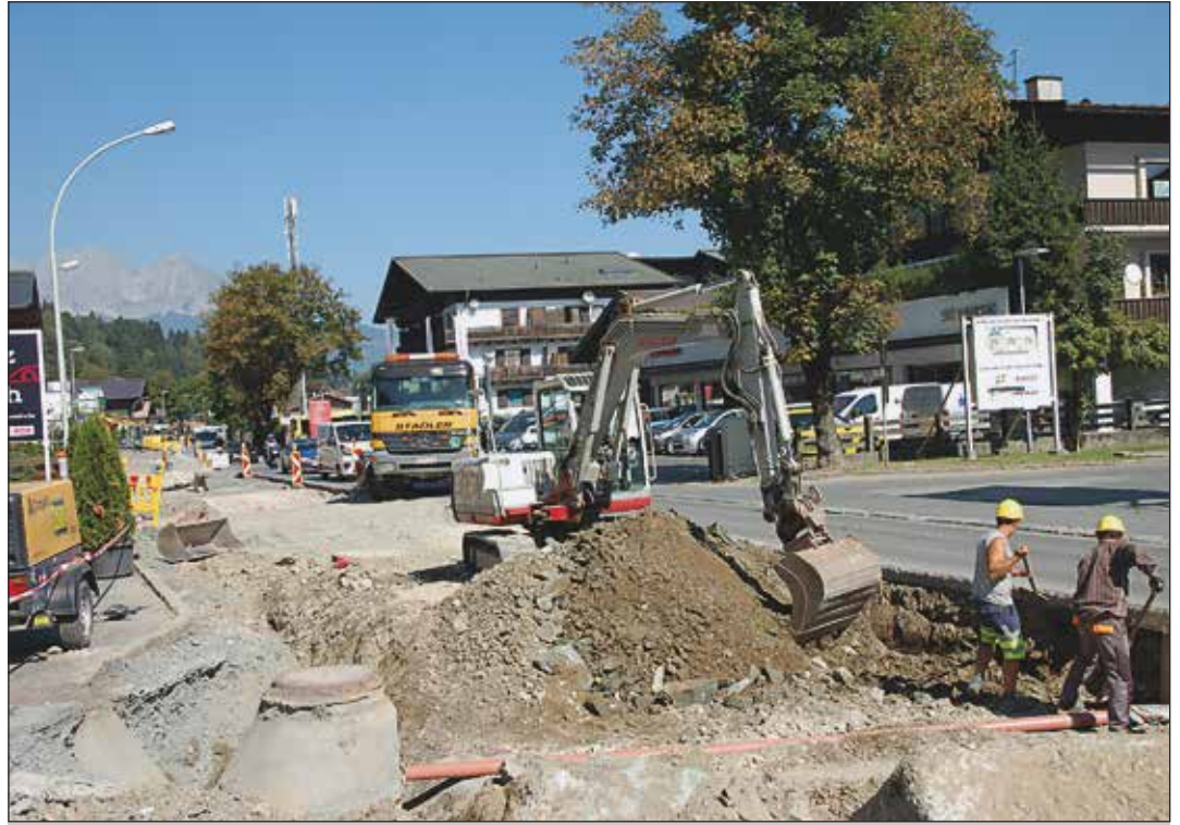
Die Sanierungsarbeiten an der St.-Johanner-Straßen dauern noch bis Juni 2017 an.
